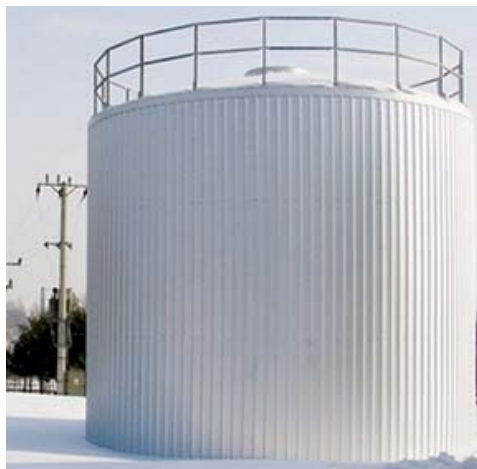
Rysunek 3.26. Zbiornik na wodę pitną dla stacji uzdatniania wody (SUW) [w2]
